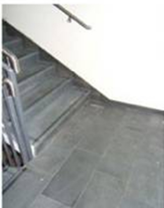
Foto 14. Detalj skiferfliser på trapp og sokkellist
