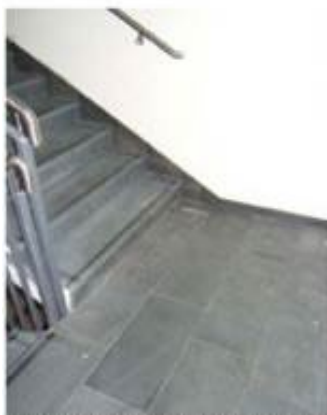
Foto 14. Detalj skiferfliser på trapp og sokkellist
