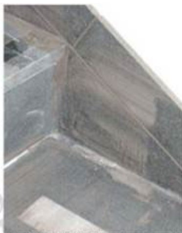
Foto 15. Detalj skiferfliser på trapp og sokkellist
