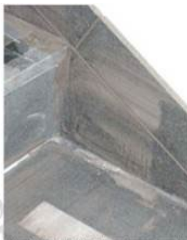
Foto 15. Detalj skiferfliser på trapp og sokkellist
