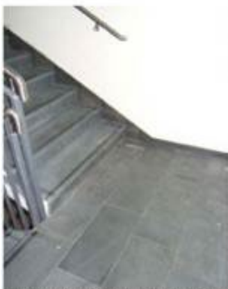
Foto 14. Detalj skiferfliser på trapp og sokkellist
